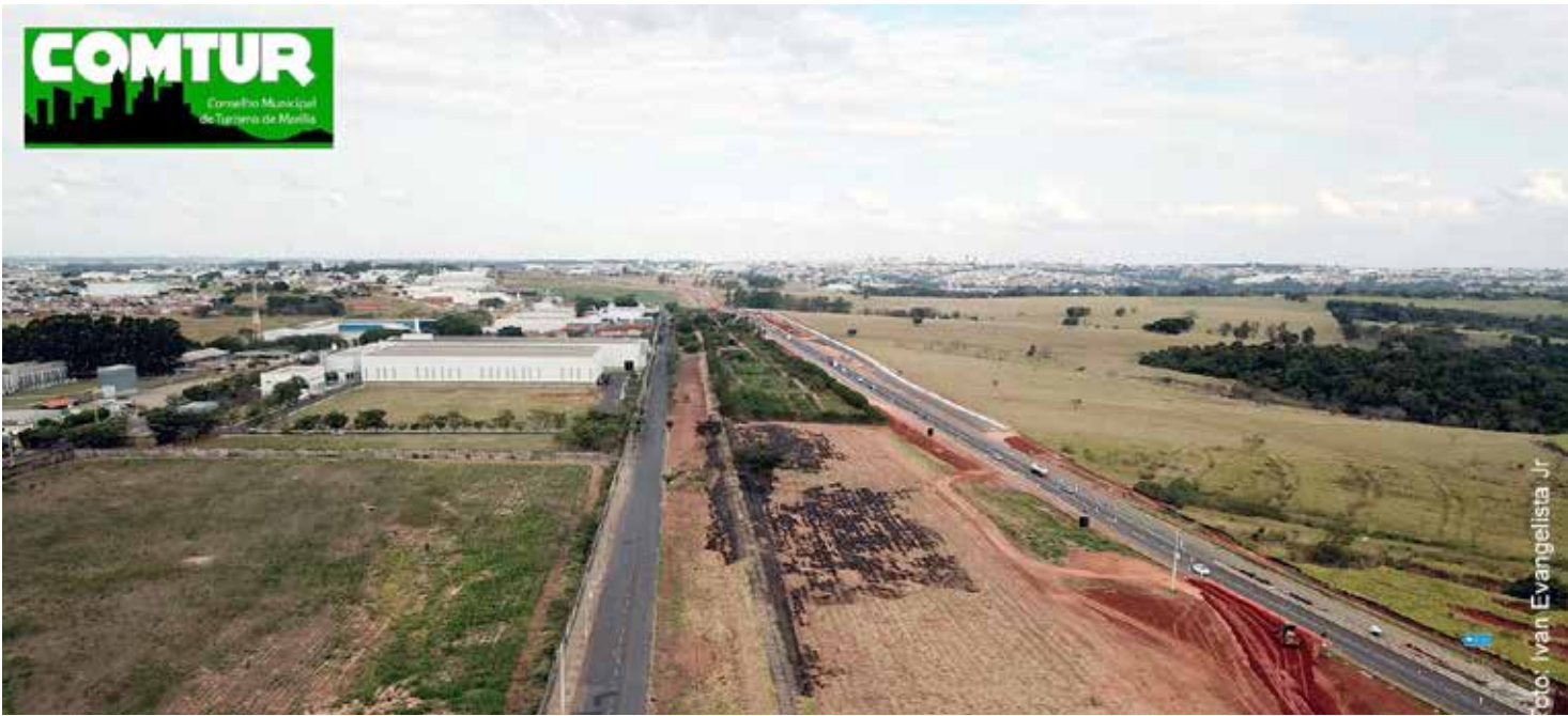
Duplicação e obras na SP 294 que demanda ao distrito de Padre Nóbrega. Ciclovia vai impulsionar movimento de turismo esportivo na região.
